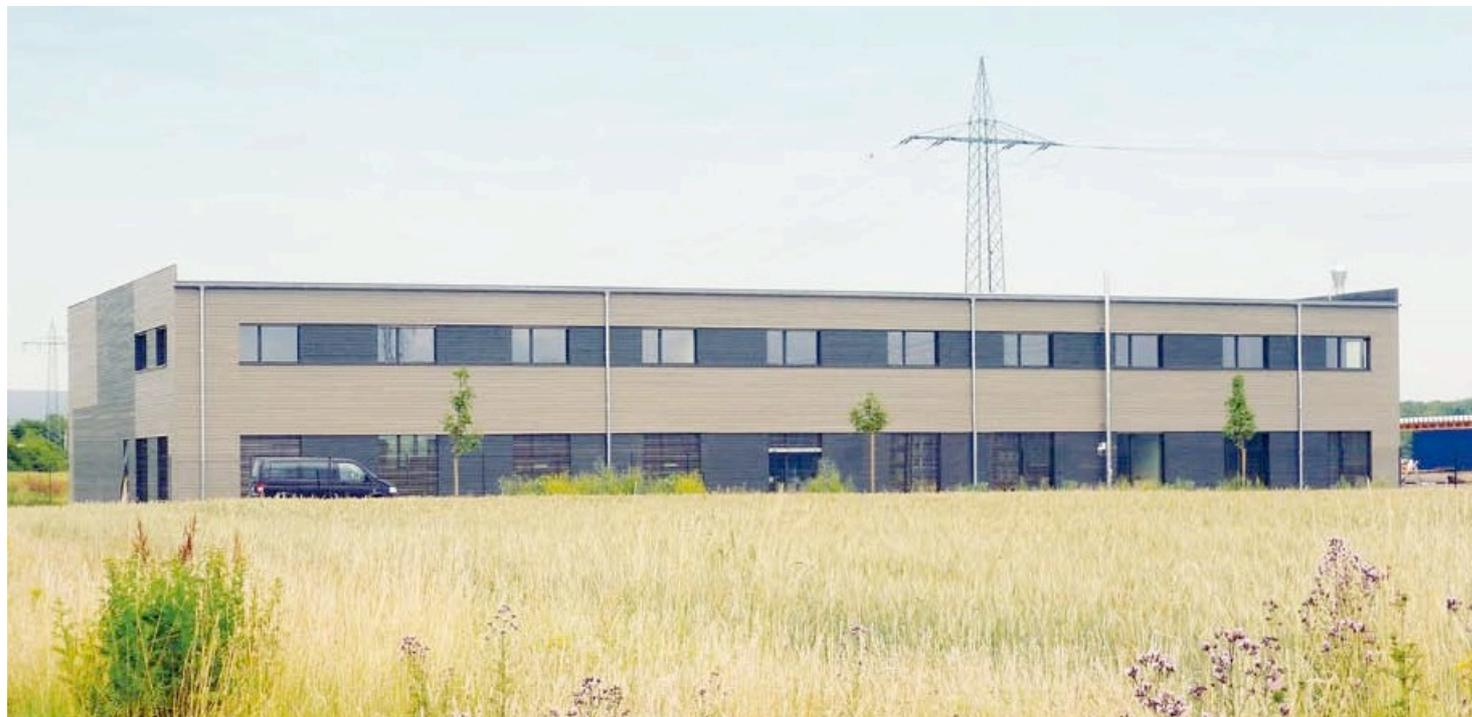
разумеется общий коэффициент теплопередачи конструктивного элемента: с 0,088 Вт / (м²К) до 0,138 Вт/(м²К). Однако для достижения стандарта "пассивного" дома это значение было все еще достаточно приемлемым.
