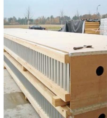
↳ Для ширины пролета цеха 14,50 м требовалась металлическая балка с перемычкой высотой 55 см
