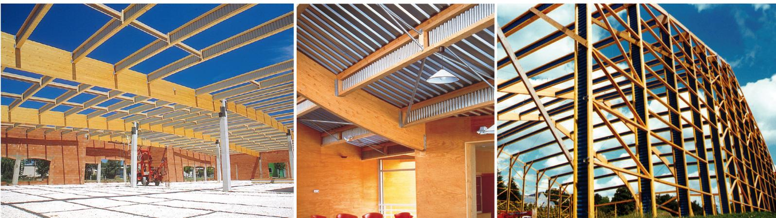
Der Einsatz von HTS-Holzträgern aus rein statischer Sicht wird erst dann sinnvoll, wenn Systeme mit größeren Stützweiten vorliegen, bei denen z. B. kein Vollholzschnitt mehr verwendet werden kann.
