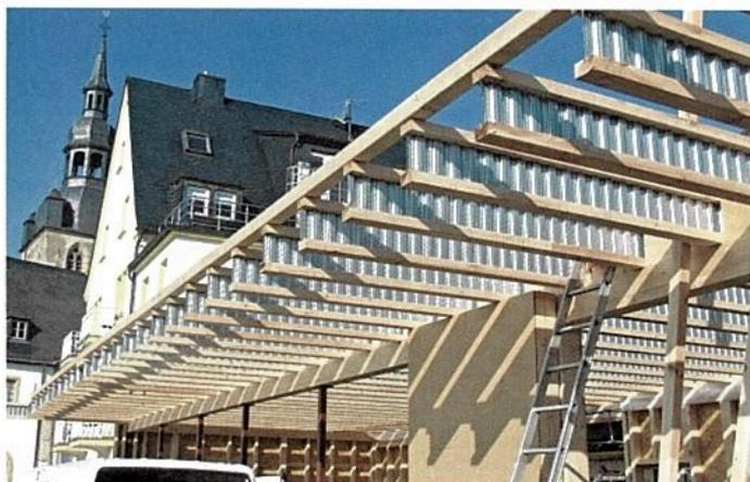
▲ Die verwendeten HTS-Holzträger vereinen die natürlichen Vorzüge von Holz mit den Vorteilen des Stahls zu einem Holzbausträger
